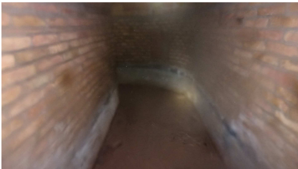
Foto 7: Tercer tram galeria.
