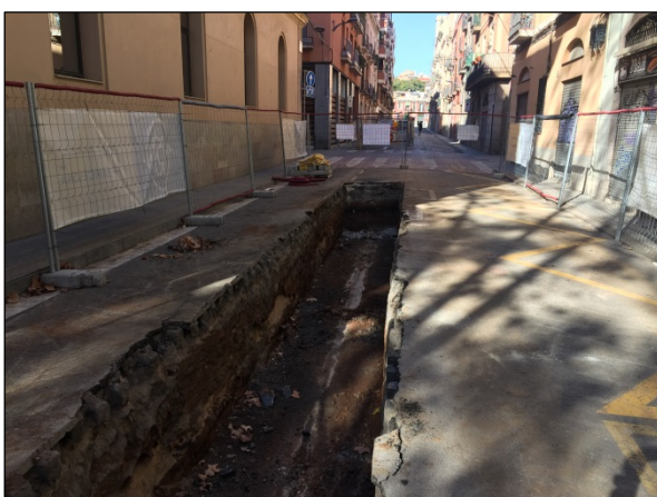
Foto 5. Apertura rasa col·lector Tram B
