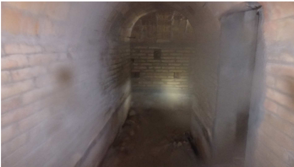
Foto 5: Primer tram galeria.
