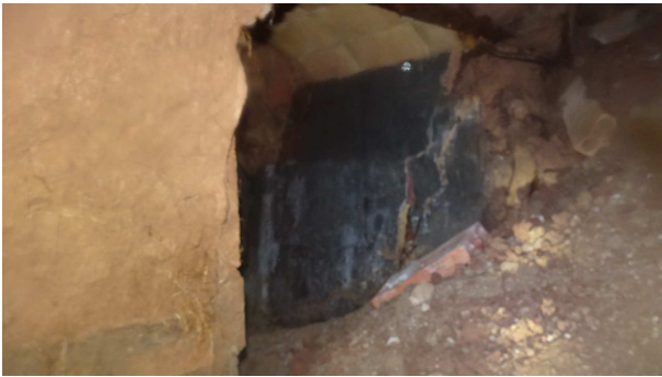
Foto 11: Cinquè tram galeria, accés sisè tram
