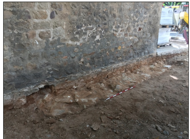
Foto 22. Cata. Detall cara interna mur UE 12
