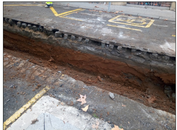
Foto 4. Detall de l'estatigrafia al tram A. Rebliment col·lector
