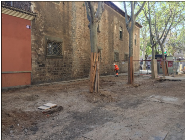
Foto 9. Rebaix del calaix al Tram A
