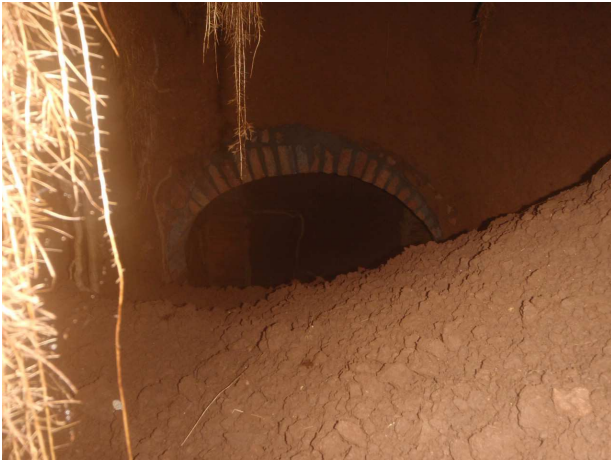
Foto 15: Tram galeria cola-lapsat.
