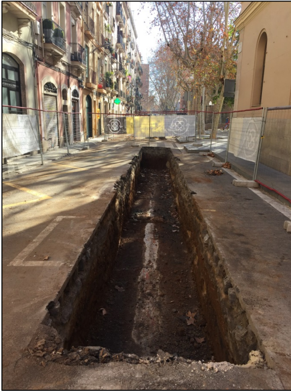
Figura 3. Excavació rasa del col·lector. s'aprecia la volta Figura 4. Estat final abans del rebaix general
