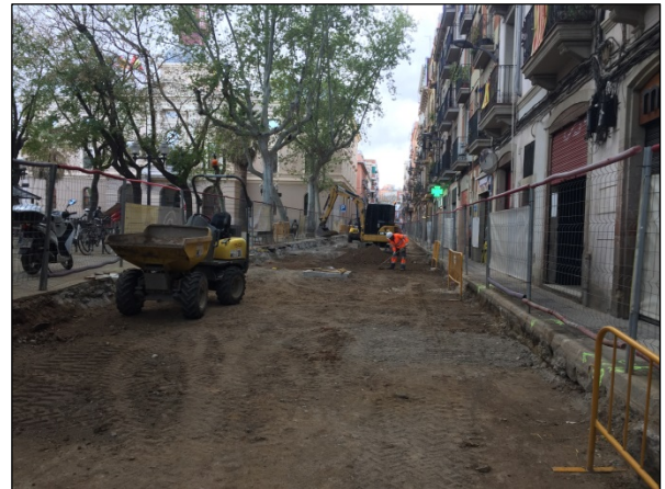
Foto 10. Rebaix del calaix al tram A
