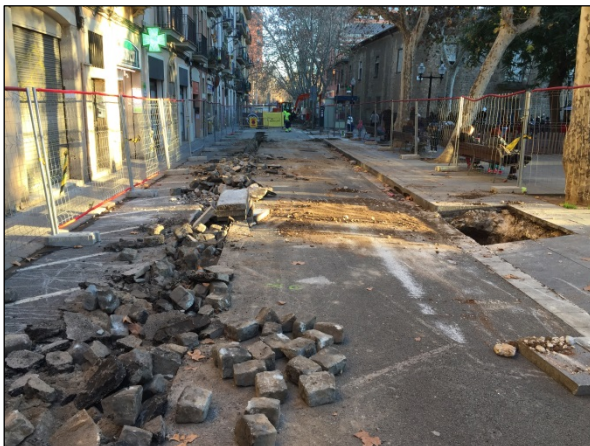
Foto 3. Inici del rebaix al tram A
