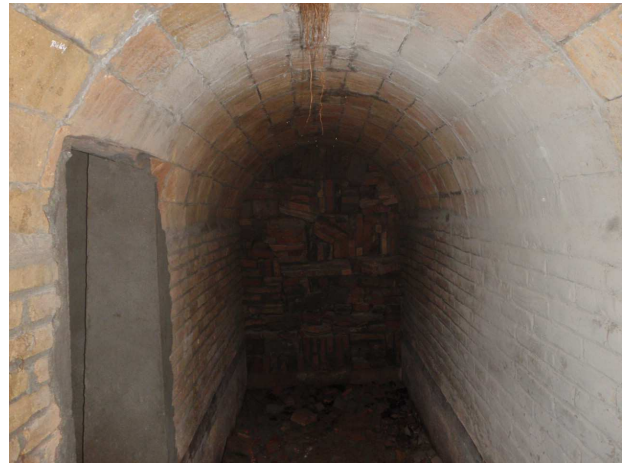
Foto 4: Primer tram galeria.
