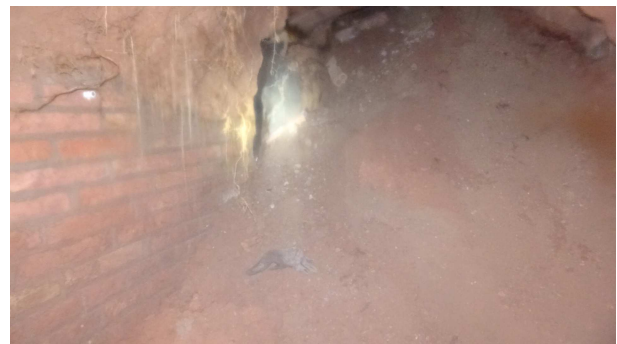
Foto 10: Cinquè tram galeria, accés sisè tram
