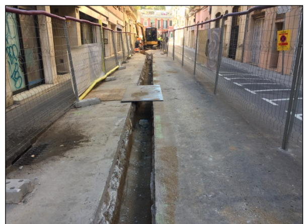
Foto 6. Rases de servei. Tram B
